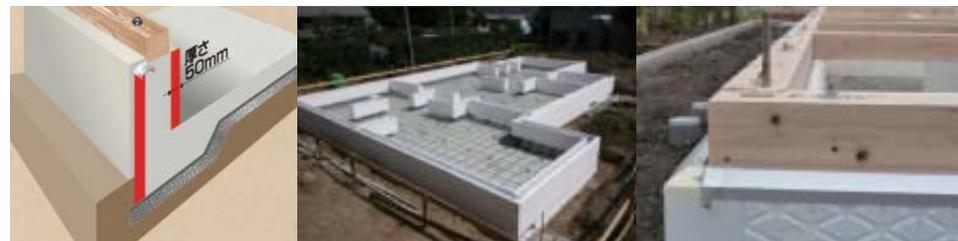
タイト・モールド工法では、断熱材がコンクリートの型枠の役割もになっています。
